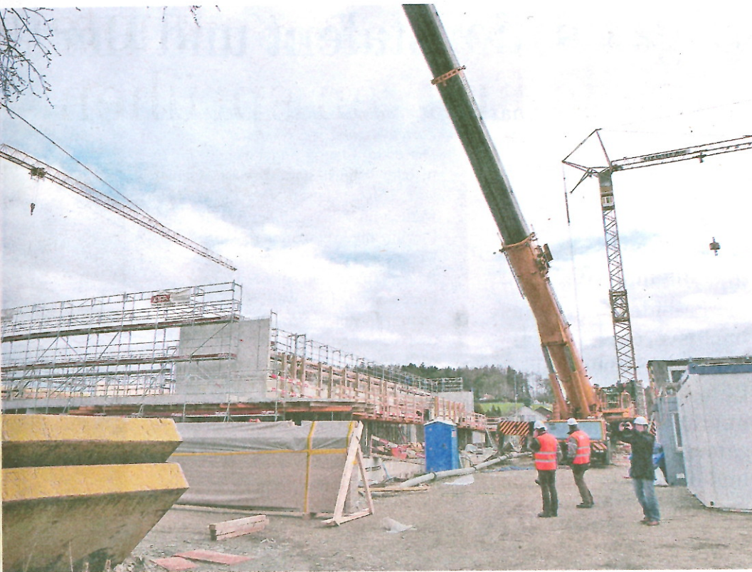
Der Pneukran der Firma Toggenburger verfügt über eine Hubkraft von 350 Tonnen.
