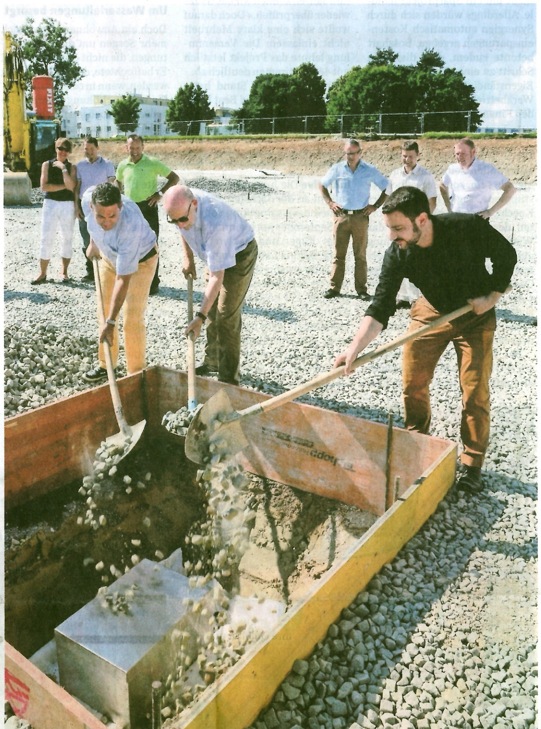
Projektleiter Stefan Mühlemann (links), Gemeindeammann Bruno Lüscher (Mitte) und Architekt Gilaad Bensimon schütten die Kasse im Fundament der Mehrzweckhalle zu.
